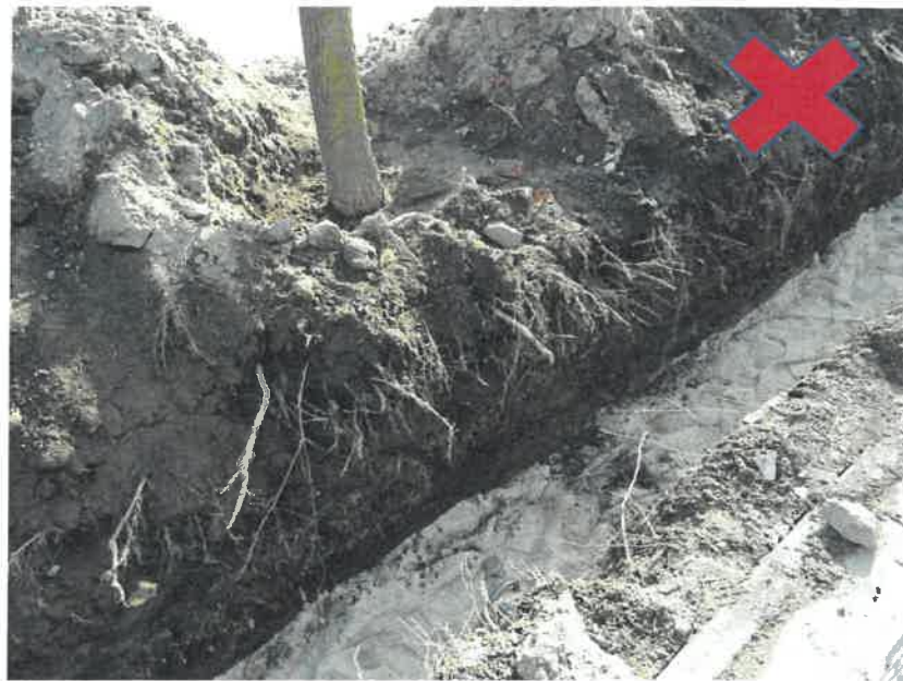
NIEDOPUSZCZALNE PROWADZENIE WYKOPÓW LINIOWYCH W STREFIE KORZENIOWEJ: 1. WYKOP ZA BLISKO PNIA DRZEWA 2. ODKRYTE KORZENIE
