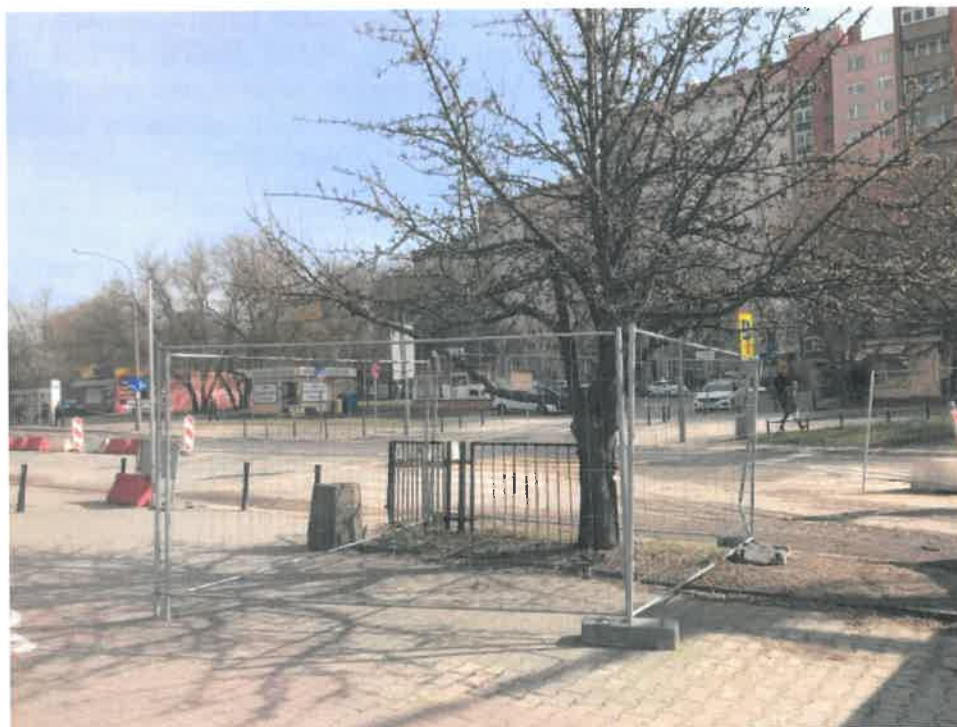
Fot. 5 Przykład wygrodzenia drzew z terenu budowy w Strefie Ochronnej Zieleni [fot. IGR, 2022]
