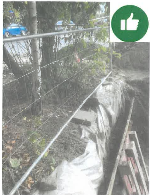
ODKRYTE KORZENIE ZWILŻYĆ I PRZYKRYĆ GEOWŁÓKNINĄ I NAWADNIAĆ REGULARNIE ABY NIE DOPUŚCIĆ DO PRZESYSCHANIA
